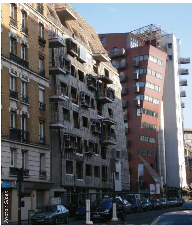
Photo : Gipen Pour réaliser les panneaux constituant le mur-manteau, l'entreprise Pavisol Idée Gipen a utilisé 62m 3 de bois.
