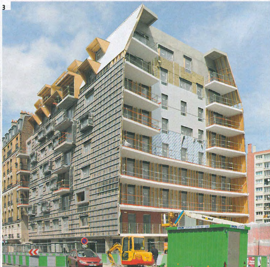
1- L'immeuble R+8 abritera 46 logements à basse consommation. 2- Les deux derniers niveaux sont abrités par une charpente traditionnelle, qui repose sur l'ossature bois des façades. 3- Le pignon réalisé en béton et les façades à ossature bois sur rue et sur jardin seront revêtus des mêmes cassettes en aluminium blanc métallisé.
