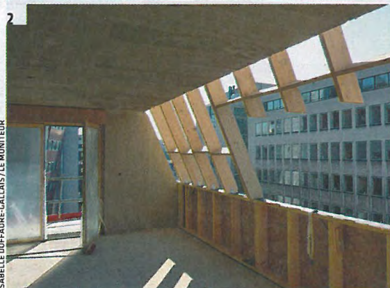
1- L'immeuble R+8 abritera 46 logements à basse consommation. 2- Les deux derniers niveaux sont abrités par une charpente traditionnelle, qui repose sur l'ossature bois des façades. 3- Le pignon réalisé en béton et les façades à ossature bois sur rue et sur jardin seront revêtus des mêmes cassettes en aluminium blanc métallisé.
